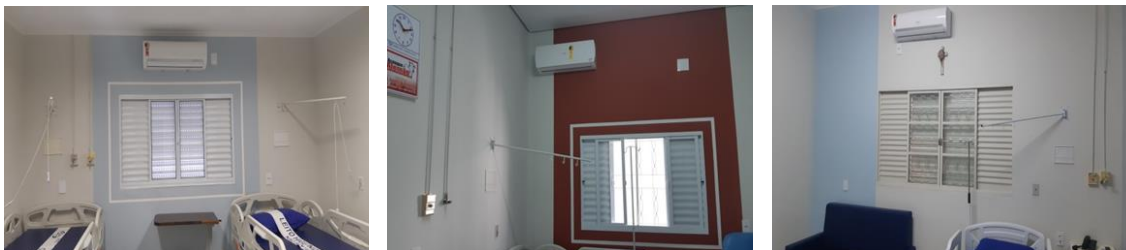
Pintura, camas elétricas e ar condicionado nas alas de internações / enfermarias
