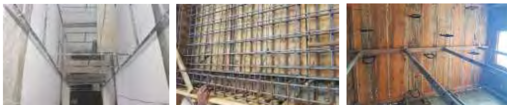
Obras em andamento – elevador
