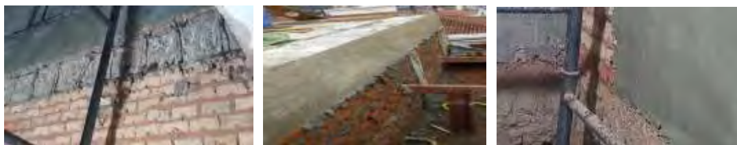
Obras em andamento – elevador
