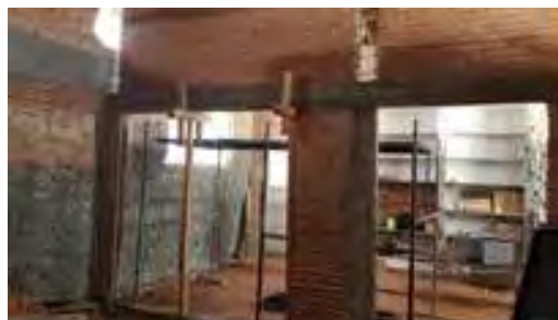
Obras em andamento - CME
